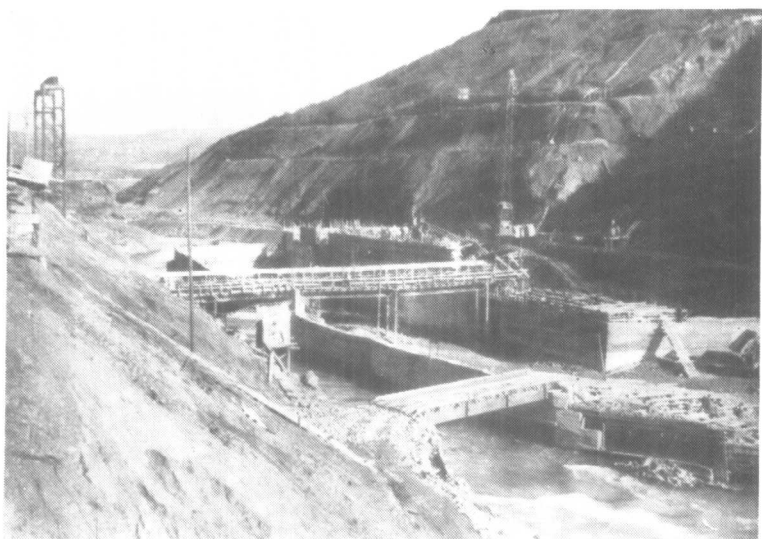
恩維爾·霍查水电站工地一角
