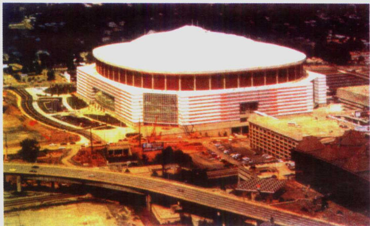
图3 亚特兰大的佐治亚圆顶体育场的膜结构顶篷
