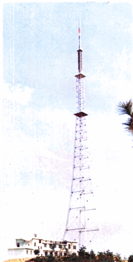
△ 1988年9月，上饶电视台建成开播，该台铁塔是目前江西省最高的广播电视综合发射塔。图为该台的铁塔和机房
