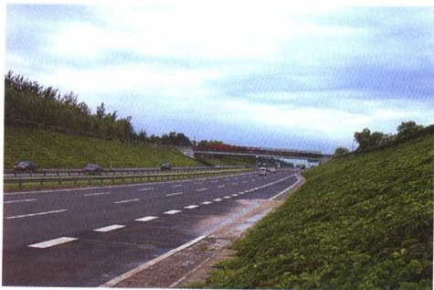
彩图 24 立交桥坡面绿化
