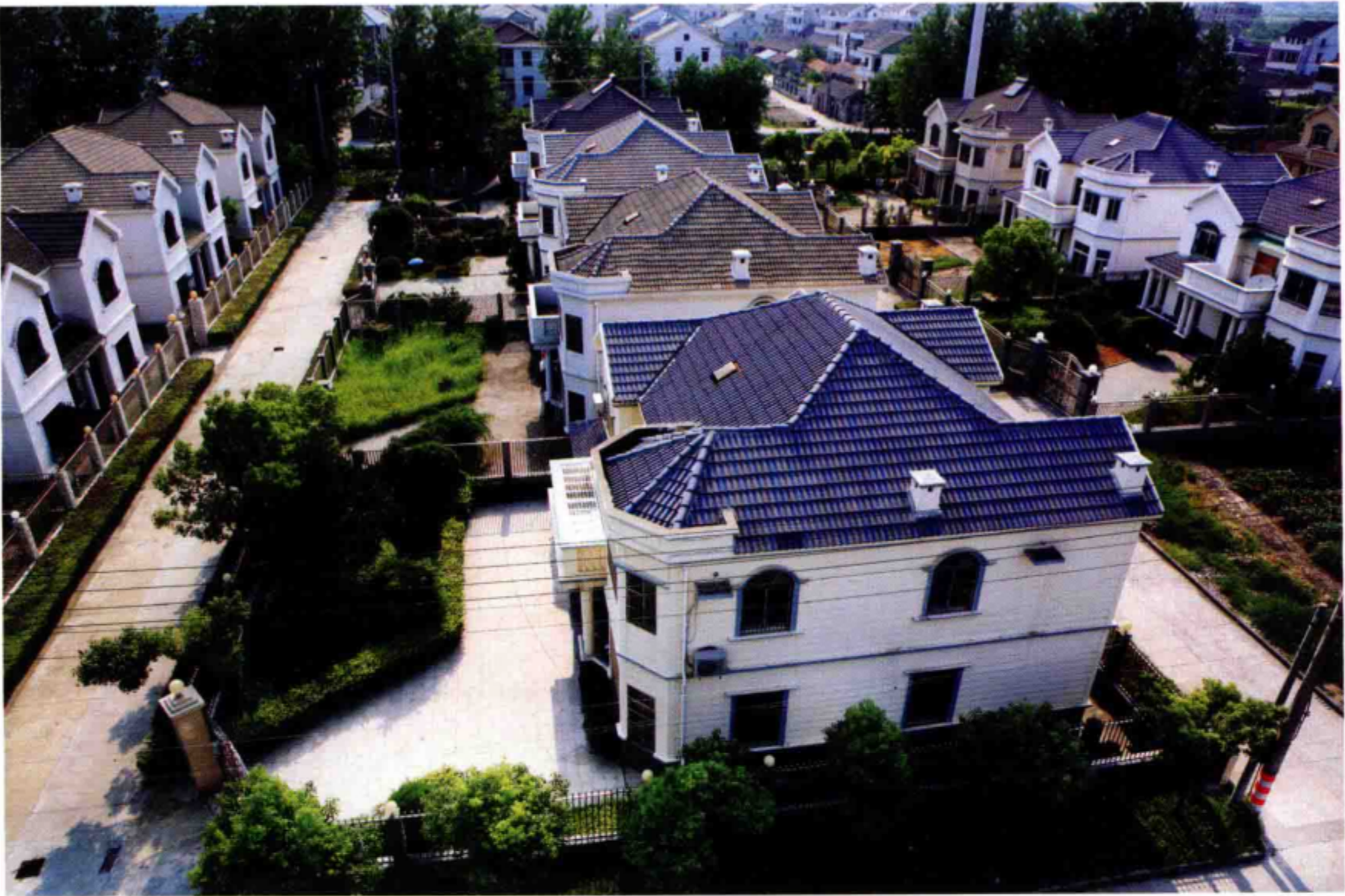
周巷镇居民住宅区
