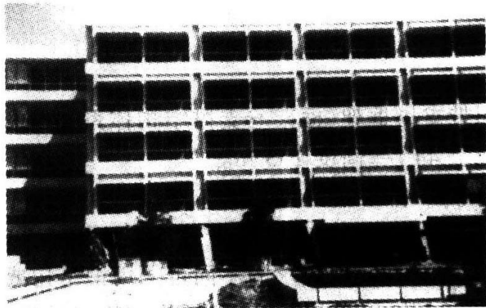
图 1.2.12 柔弱底层的纵向侧移
