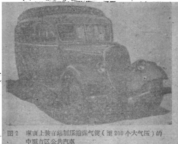
图2 車頂上裝有鋁制壓縮煤氣筒（至200個大氣壓）的
