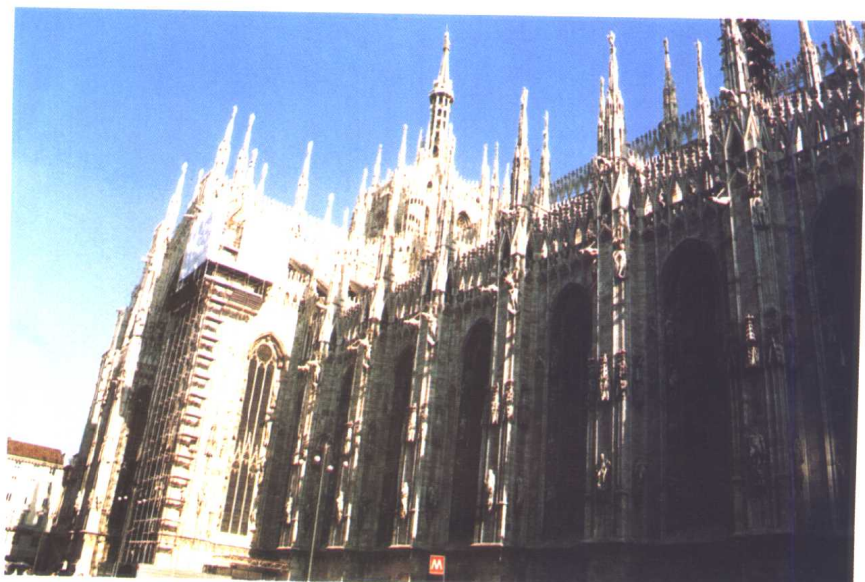
正在维修的米兰大教堂
