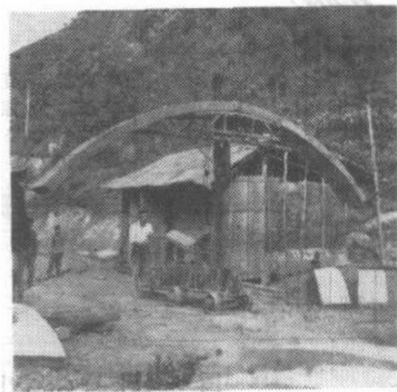
图5 拱板提升情况
