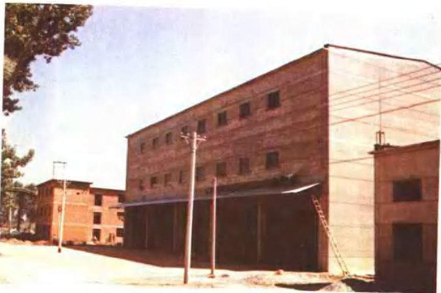
中试厂保护渣车间厂房
