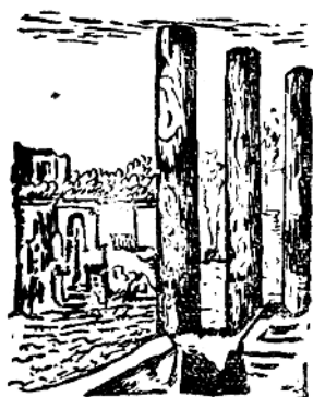
圖13 尤比切爾古廟石柱 (石柱黑色部分就是受蝕部分)
