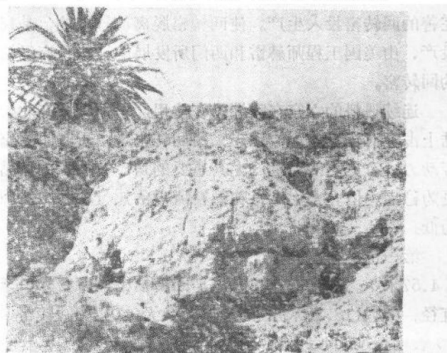
图 1-1 早期加利福尼亚移民把石灰石烧成石灰的地下炉遗迹
