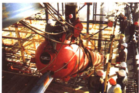
现场吊装设备
