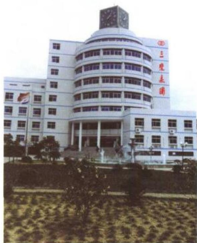
三变科技大楼
