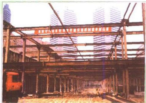
北京国贸大厦二期大直径钢支护基础土方工程
