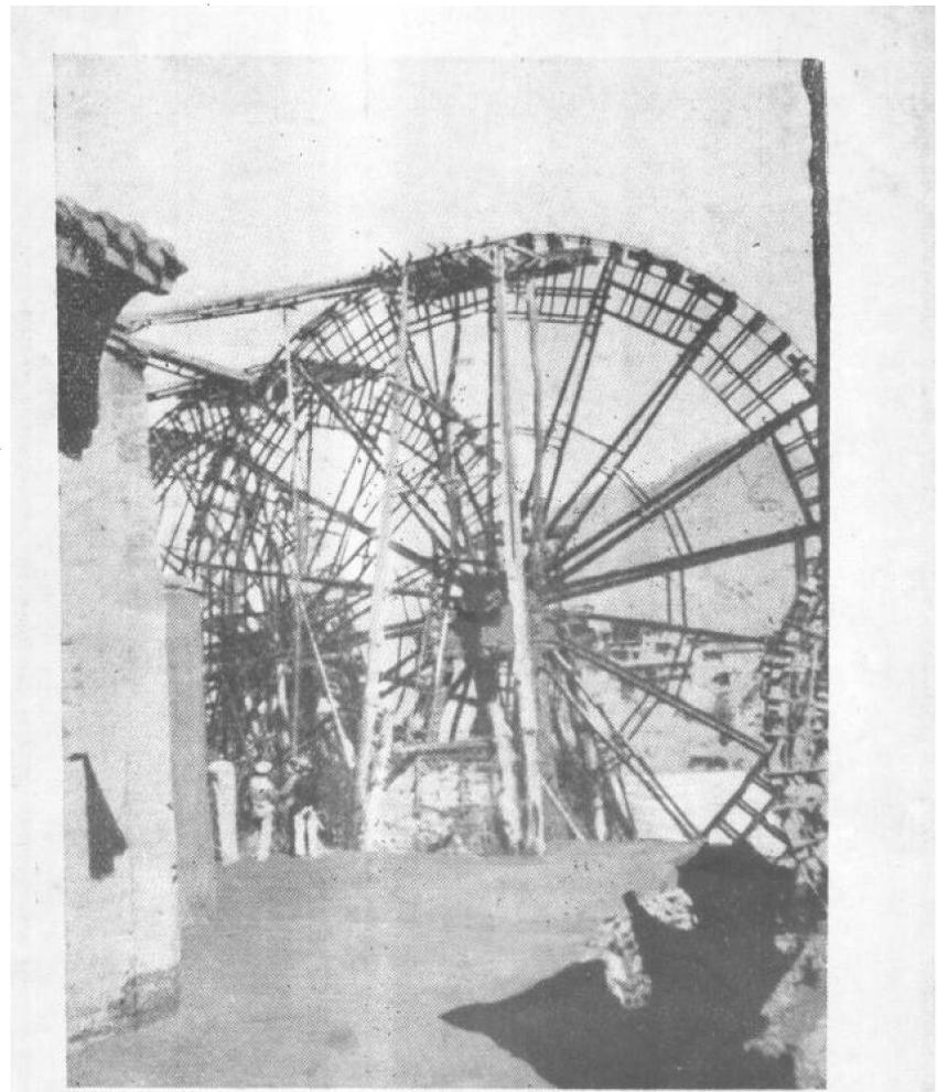
水車 黃河上游，甘寧一帶，多利用河流水力，以推動水車，車周裝置水屏，隨車之轉動，載水上升，以供灌溉之用。圖為皋蘭黃河之水車，輪徑約二十公尺，載水屏二十八，其水先由水屏傾於高架之輸水槽內，再轉入灌溉渠中，其給水量約為每分鐘五立方公尺。此為利用水力之原始機械，近則日見改進，而效率較前亦大增矣（圖為李儀祉先生攝贈）。
