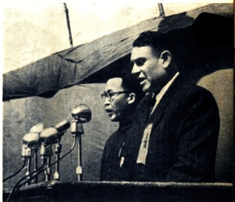
蘇聯施工輔助企業專家組組長波赫，熱烈祝賀三門峽水利樞紐工程開工。
