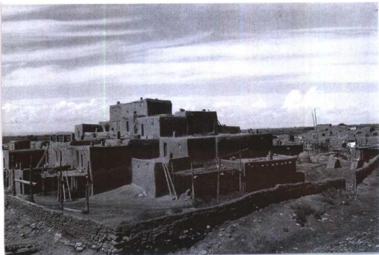
图1 新墨西哥州一个以土块建成的村落，其中每个居住空间都是基本的单间住宅
