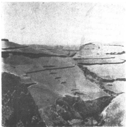
照片49 在徑流集中的黃土坡地上修水簸箕，即迎水凸弧土埂。
