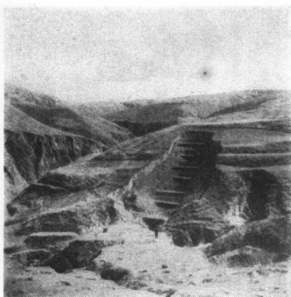
照片53 黃土坡上沖溝底部的土谷坊，并在谷坊上造林。
