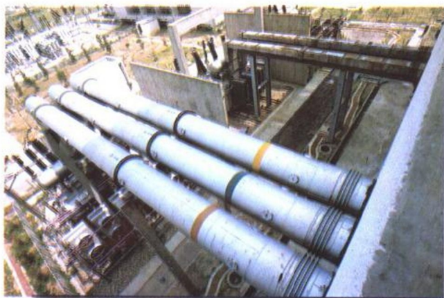
1988 年荣获国家质量银质奖，曾为我国第一座核电站（秦山核电站）配套的设备—全连式离相封闭母线
