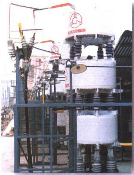
国内首家研制成功并按国际 IEC 标准 生产的干式空芯电抗器
