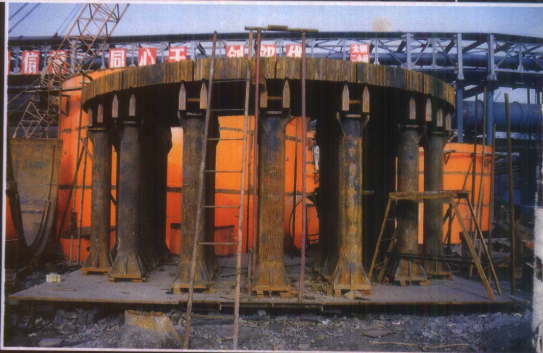
热风炉炉柱、炉箅子预组装
