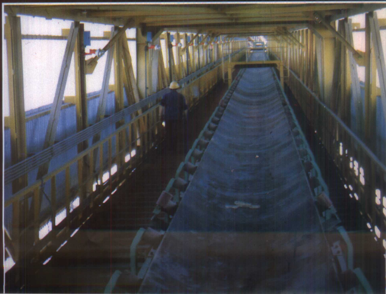
上料主皮带通廊
