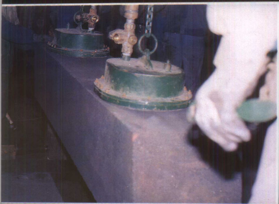
真空吸盘吊砌筑大型炭砖
