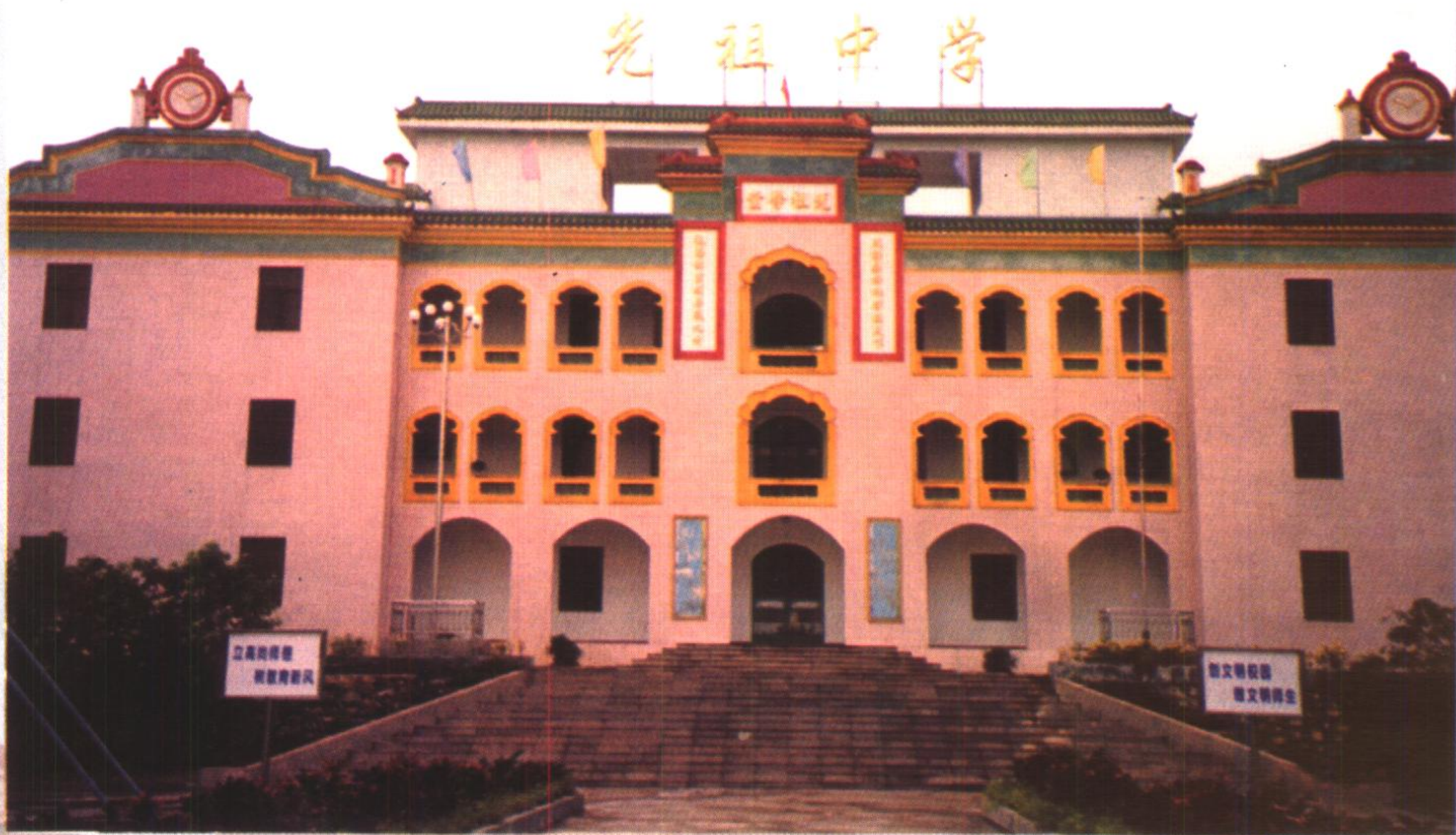
坑梓“光祖学堂”主楼
