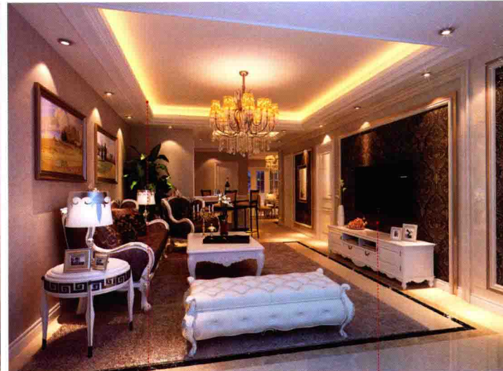
石膏板吊顶暗藏灯带
