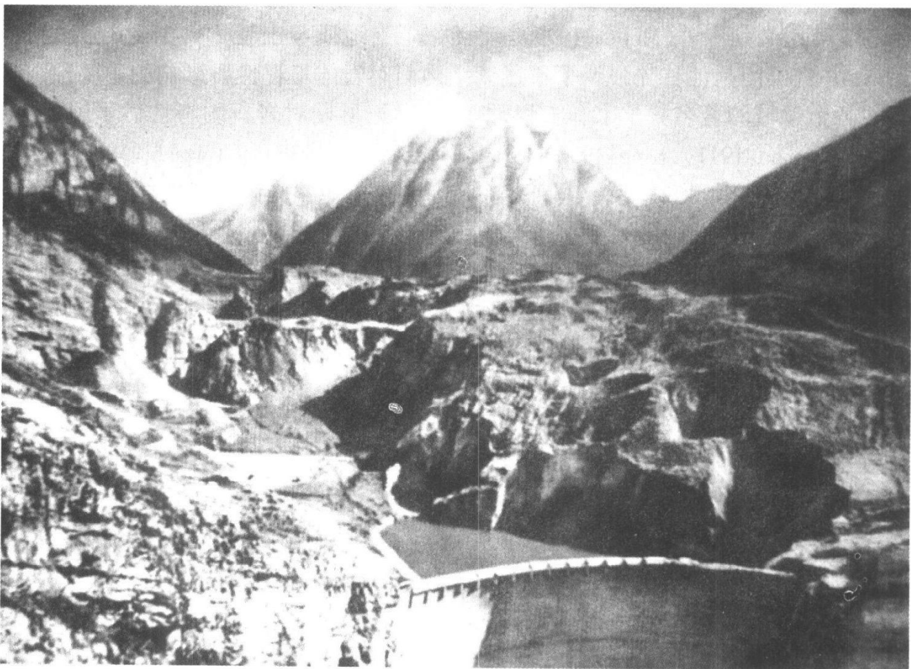
图 1-1(b) 瓦依昂 (Vajont) 水库蓄水时, Toc 山的坡脚侵入水中并由此而产生了滑坡 (在照片的中间, 滑坡堆积物清晰可见。极高速度的下滑的滑坡物质排开的库水产生了 100 m 高的涌浪, 越过坝顶的防浪墙。从照片前景可见大坝本身未受大的破坏)
