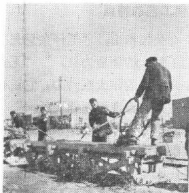
图1 用翻轉脫模生产构件
