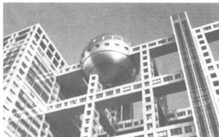
☆1 表现天圆地方的富士电视总部大楼。 设计：丹下健三。东京都港区，1996年。
