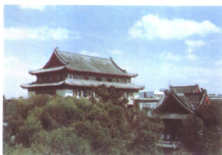
古朴、庄重的一大楼
