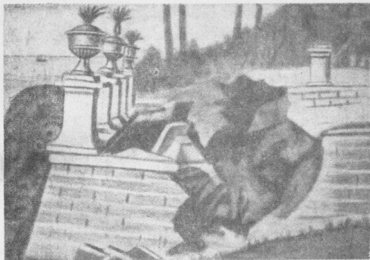
圖 1. 索奇海濱公園廣場及階梯被滑坡破壞的情況
