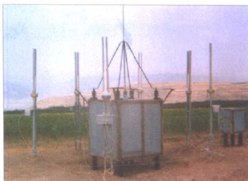
图9-2a 1997年中国平凉引雷试验现场 (中间为引雷点及测试室, 两侧为发射架)
