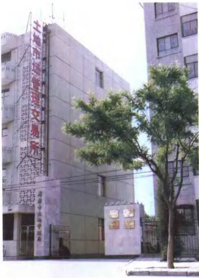
◀ 廊坊市土地管理局门口 (1996年)
