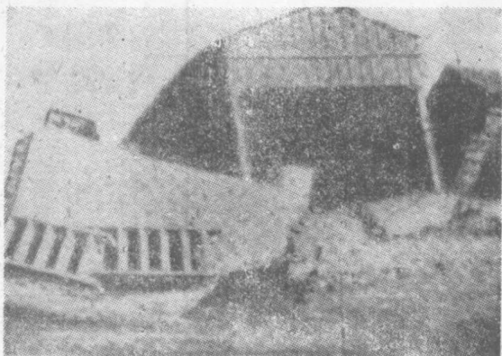
图 1 滑坡发生引起建筑物的破坏
