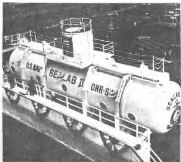
圖9 1965年美國海軍在“人類在海中”計劃下從事了45天的實驗，十名船員在加利福尼亞州的La Jolla外海，海平面205呎下生活和工作。他們的海底基地是海實驗室二號（Sea lab II）上面的照片攝於命名儀式時，下面的攝於潛水前的最後檢查。他們從事些實驗性的救護工作，海底研究，並經過了一系列的生理和心理測驗。
