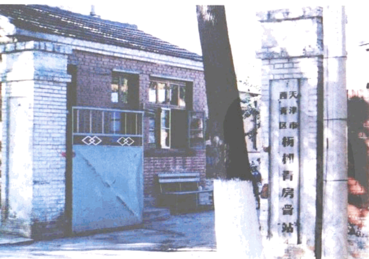
天津市西青区杨柳青房管站
