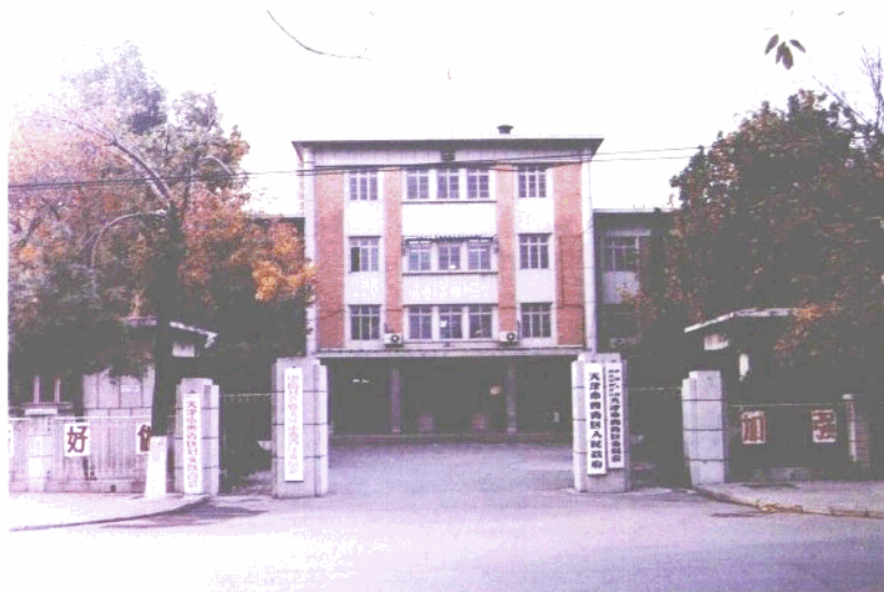
天津市西青区人民政府大楼
