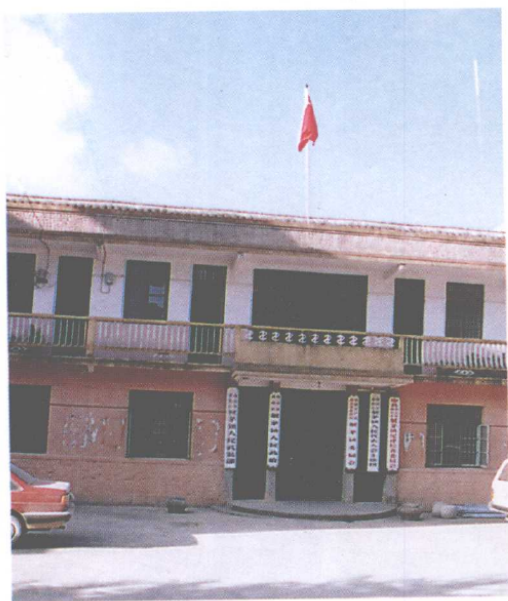
中共展茅镇委、镇人民政府办公楼
