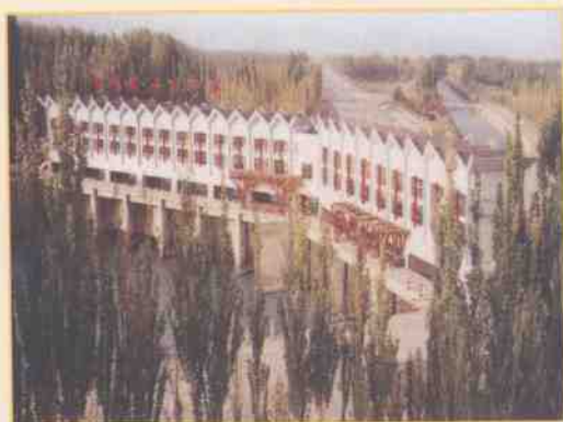
照片 19 叶尔羌河卡群渠首西岸进水冲沙闸 [21]
