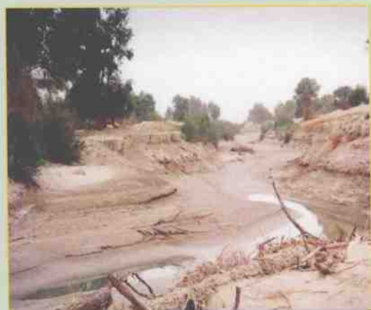
照片 39 中游跑水沟 [11]
