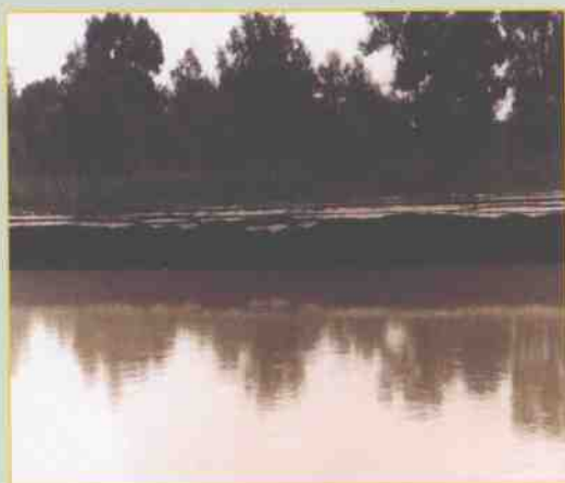
照片 37 中游河道的岸滩崩塌 [11]
