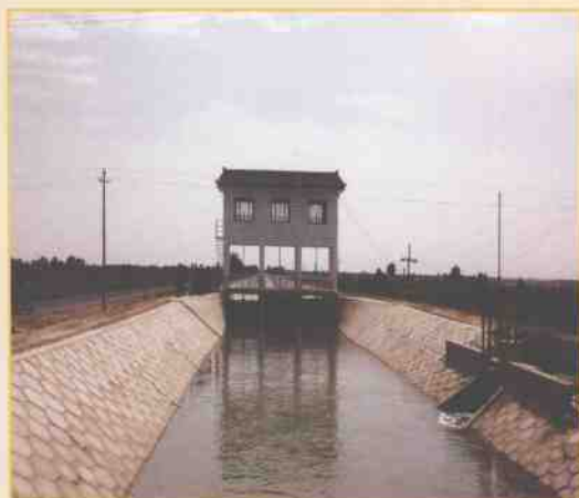
照片 22 叶尔羌河勿甫渠首与渠道 [12]
