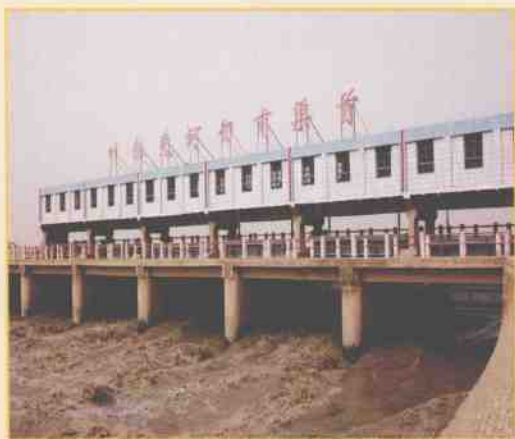
照片 21 叶尔羌河勿甫渠首 [12]
