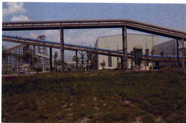
厂区绿化 处处生机
