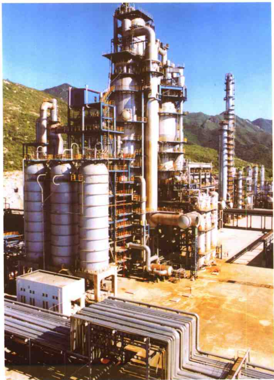
国内第一套 200 万吨 / 年重油催化裂化装置
