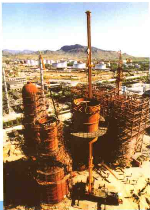
闻名全国的乙烯改扩建工程 施工现场
