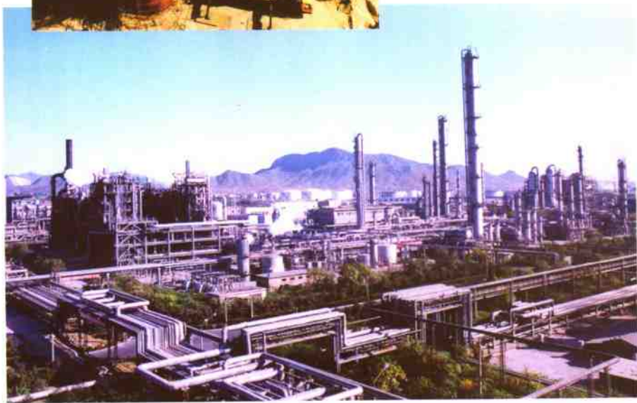
实施乙烯改扩建工程后, 热化乙烯生产能力由30万吨/年增至 45万吨/年。图为45万吨/年乙烯装置全景。
