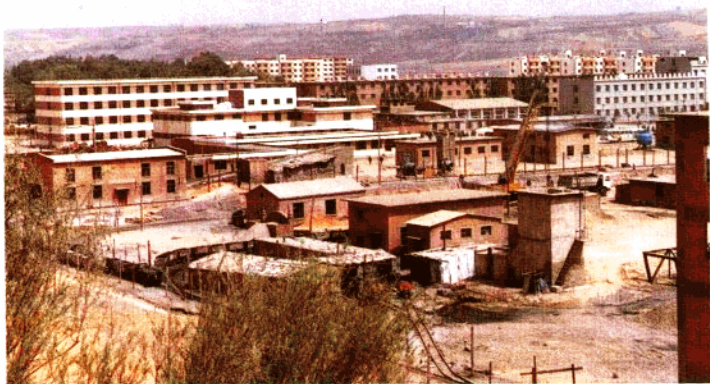
补连塔煤矿职工生活区
