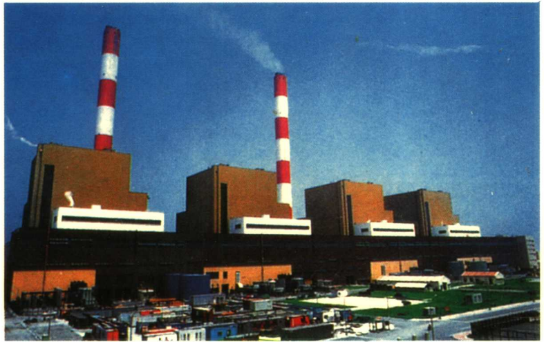
13. 台中火力发电厂（台湾电力公司， 4 \times 550 MW，另有 4 \times 72 MW 燃气轮机组，参见条目台中火力发电厂）
