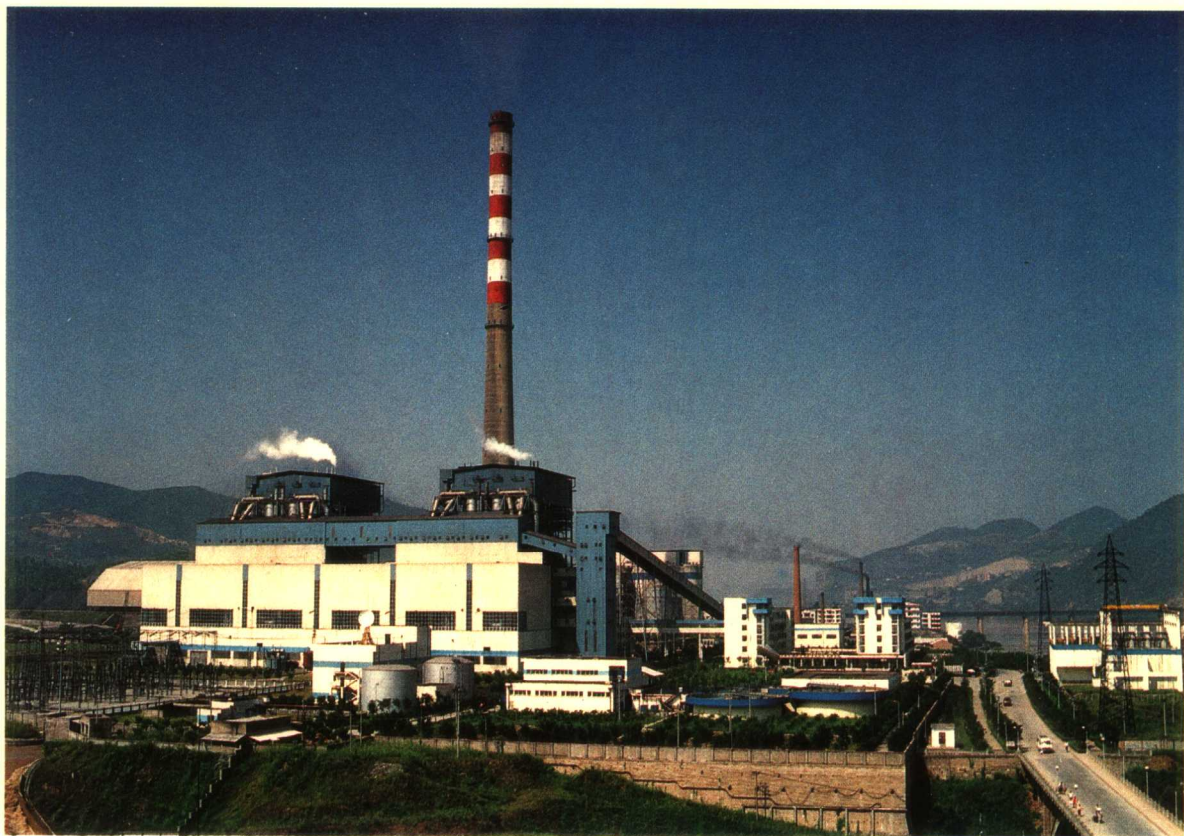
10. 华能珞璜电厂全景 (2×360 MW, 参见条目华能珞璜电厂)
