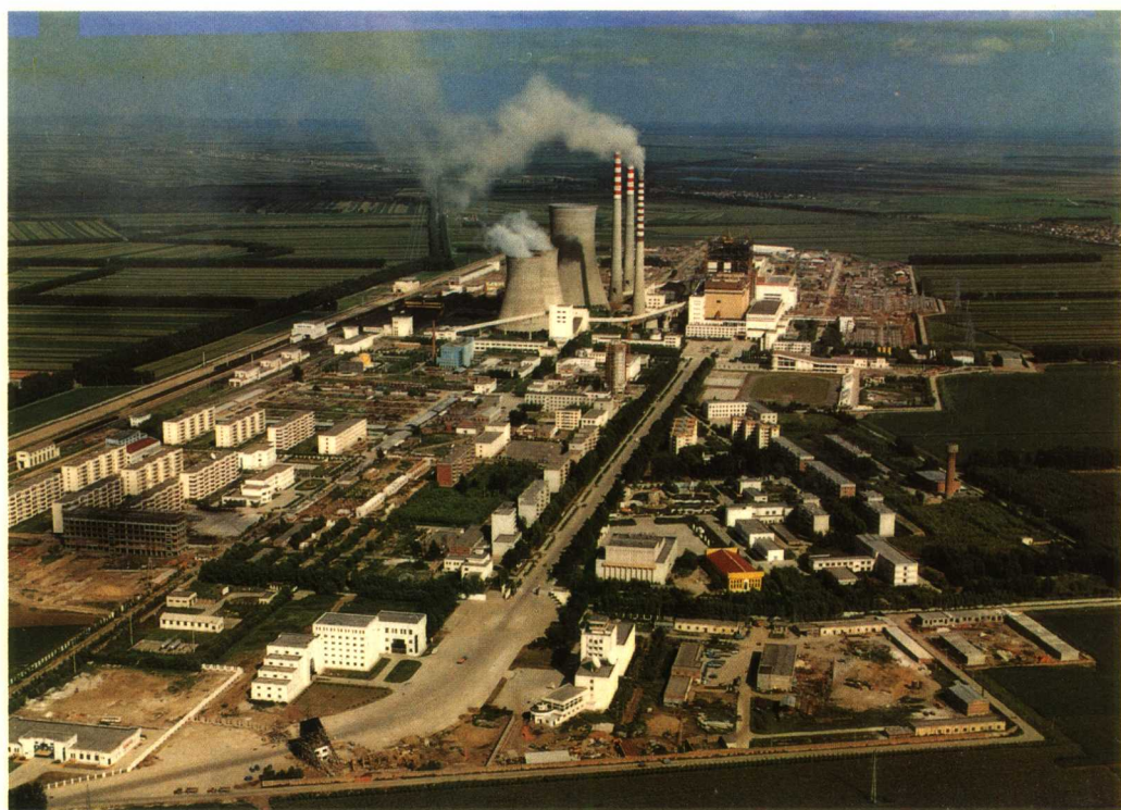
7. 哈尔滨第三发电厂鸟瞰 (2×200 MW+2×600 MW, 参见条目哈尔滨第三发电厂)
