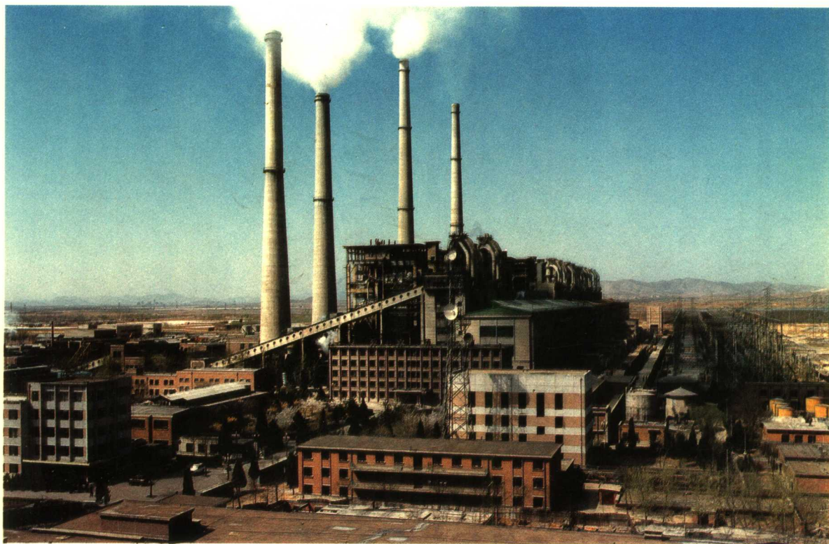
11. 陡河发电厂全貌 (2×125 MW+2×250 MW+4×200 MW, 参见条目陡河发电厂)
