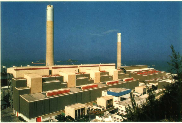
12. 青山发电厂 A、B 厂（香港中华电力公司，A 厂 4 \times 350 MW，另有 4 \times 60 MW + 2 \times 56 MW 燃气轮机组，B 厂 4 \times 677.5 MW，参见条目青山发电厂）
