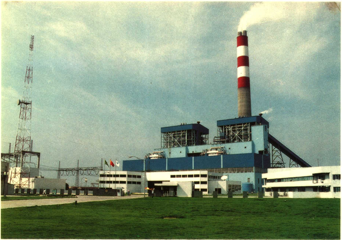
8. 华能上海石洞口第二电厂外貌 (2×600 MW 超临界压力机组, 参见条目华能上海石洞口第二电厂)
