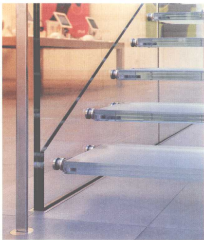
图1-11 安全强化玻璃制作的楼梯营造了一种“通灵”的视觉与“高科技”的感受。 (摘自 Spaces Architecture in Detail )
