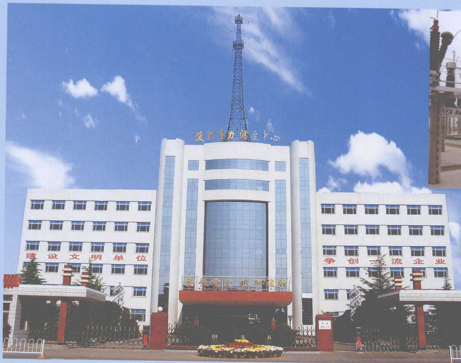
电力调度中心
