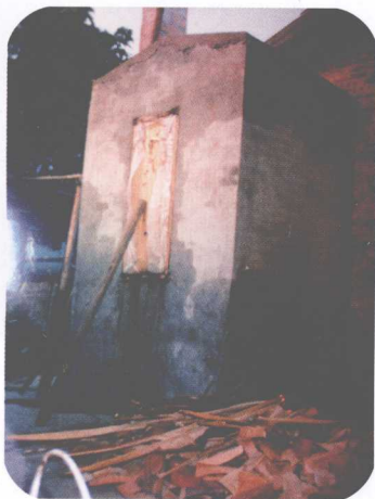
图2-5 用砖、钢筋和水泥砌成的砖砌灭菌灶
