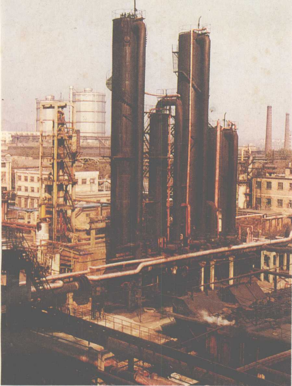
涟源钢铁厂焦化厂 回收车间污水处理装置。
