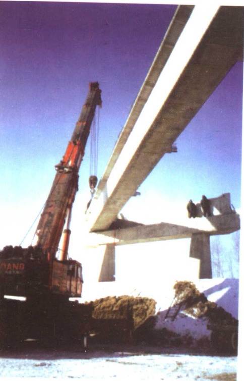
巨臂擎大梁—— 长余高速公路天桥吊装
