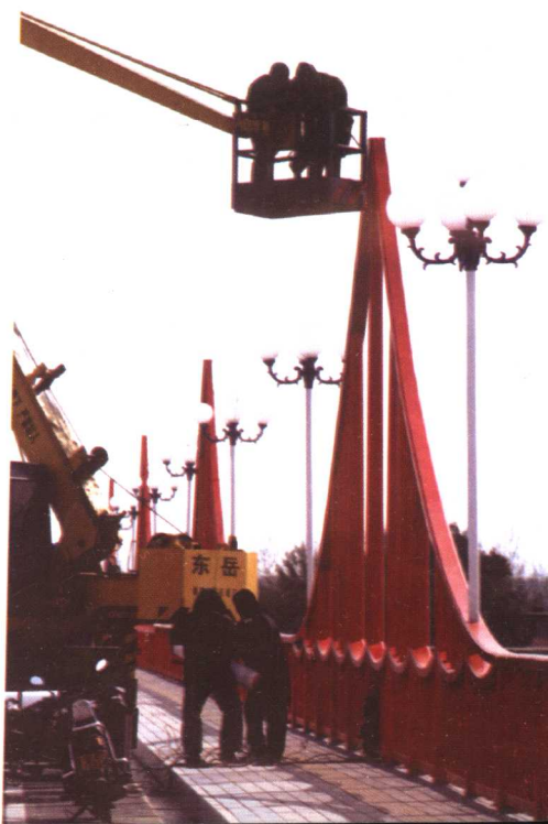
巧手扮靓装—— 建国大桥桥栏安装
