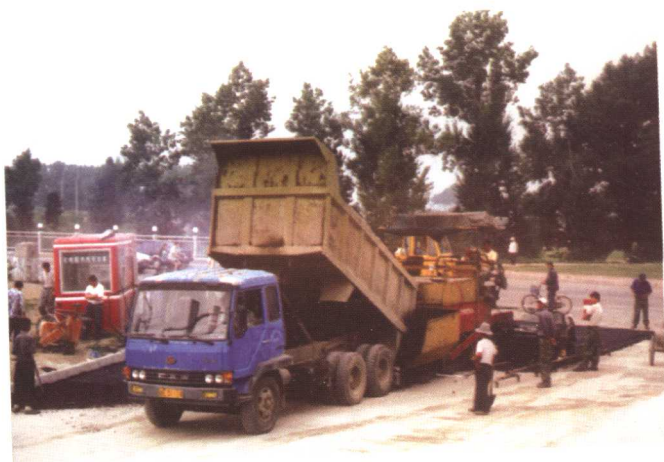
常青堤路面摊铺
