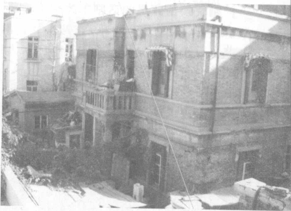
天津民主道 23 号曹禺故居后楼与前楼
