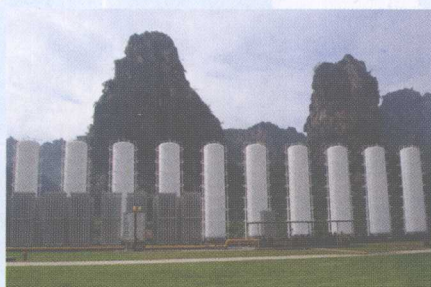
10×100m 3 /d LNG汽化站
