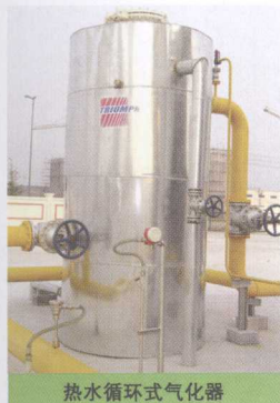
热水循环式气化器
