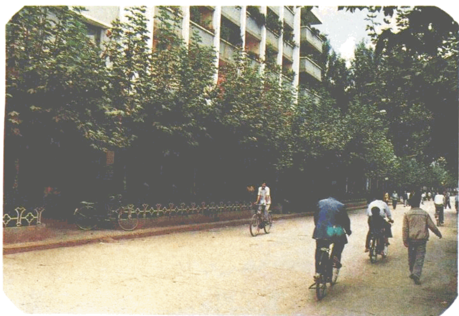
富民县糖业烟酒公司大楼
