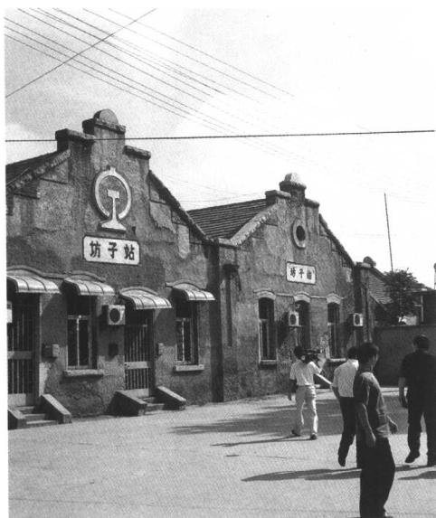
按二級火車站標準修建的坊子車站
