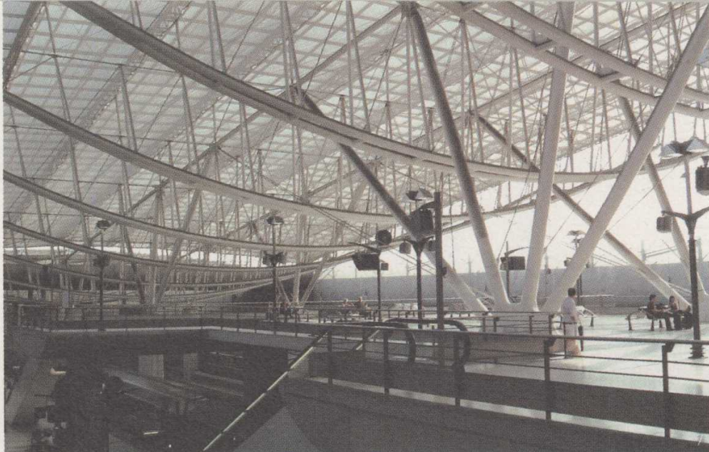
(图7)RER车站的候车月台。白色的钢管支柱及倒垂的拱形桁架重重叠叠,构成一张复杂的网。
