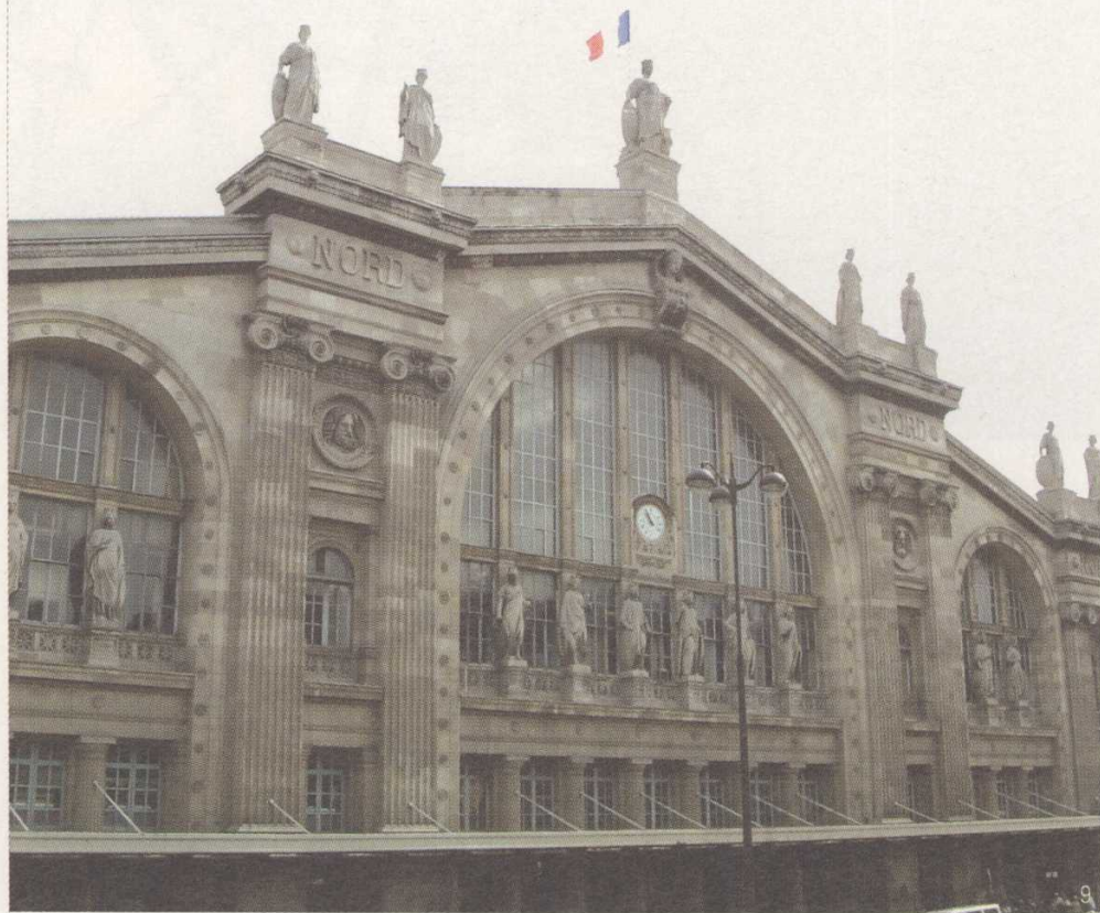
(图9、10)巴黎北站。古典的外观及内部的开放式月台空间,与一旁新颖的地铁车站,构成新旧对照的历史感。
