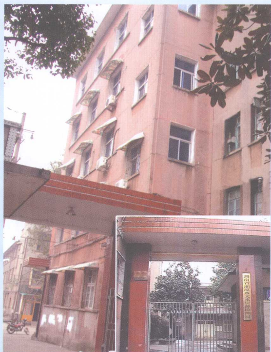
湘潭水文局机关办公大楼（2006年）
