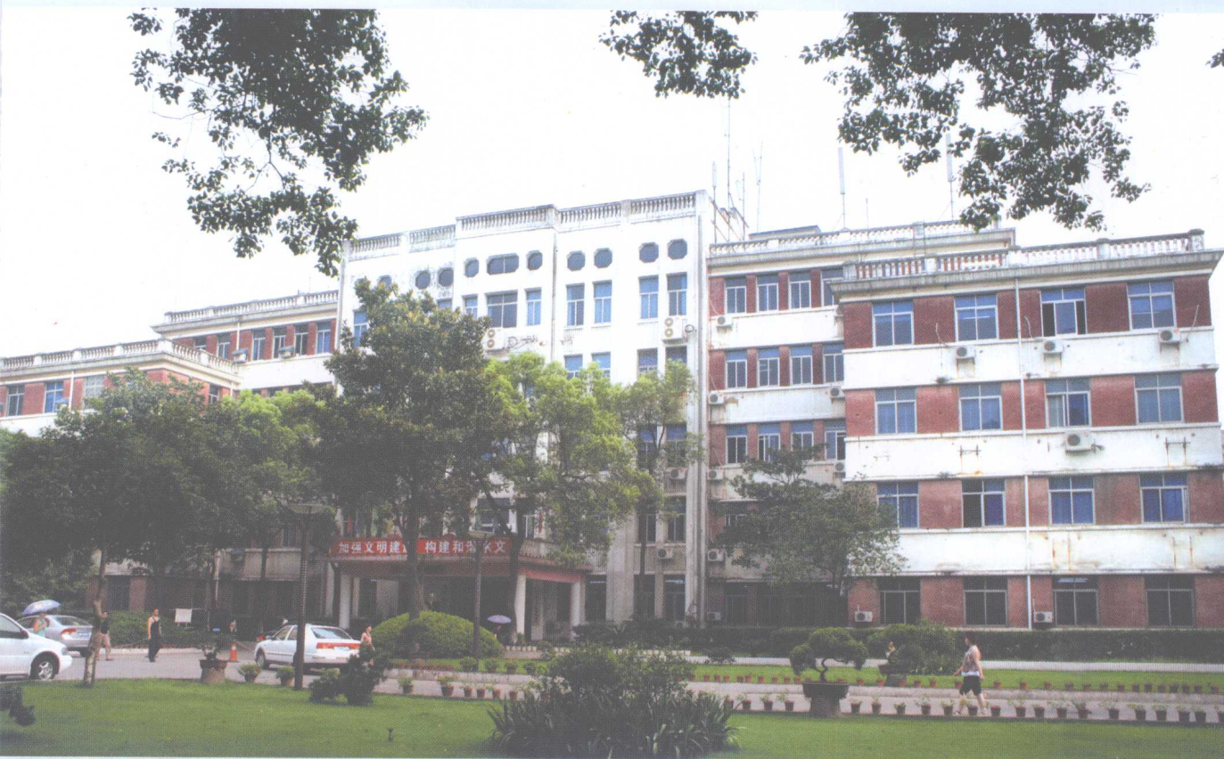
湖南省水文局办公大楼（2006年）
