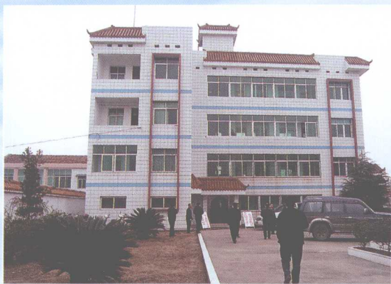
衡阳水文站办公楼
