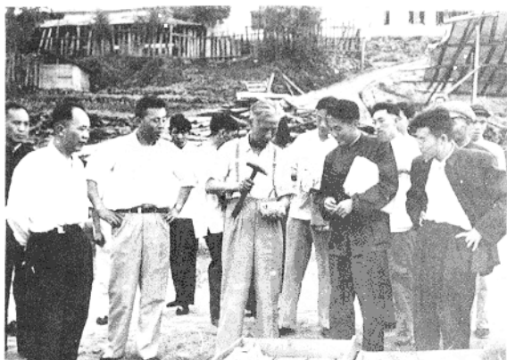
刘少奇同志视察三峡坝址勘查工地
